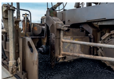
Décapage des résidus bitumeux
