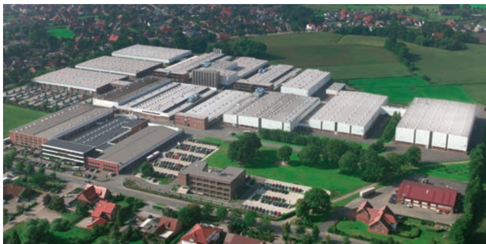
Allemagne, site 1 : Pöppelmann GmbH & Co.KG, Kunststoffwerk-Werkzeugbau, Lohne
