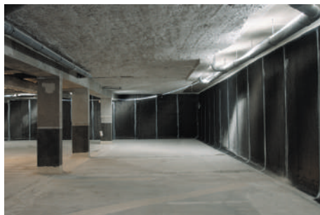
RENFORT DE STRUCTURE
