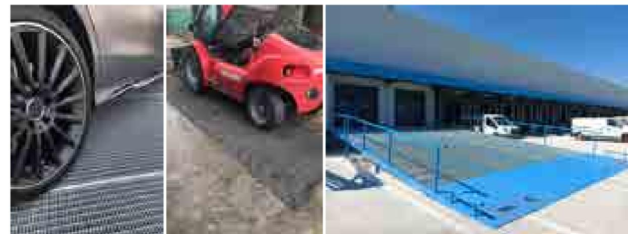
Le caillebotis pour charge lourde est également réalisable sur fabrication en caillebotis électroforgé.
