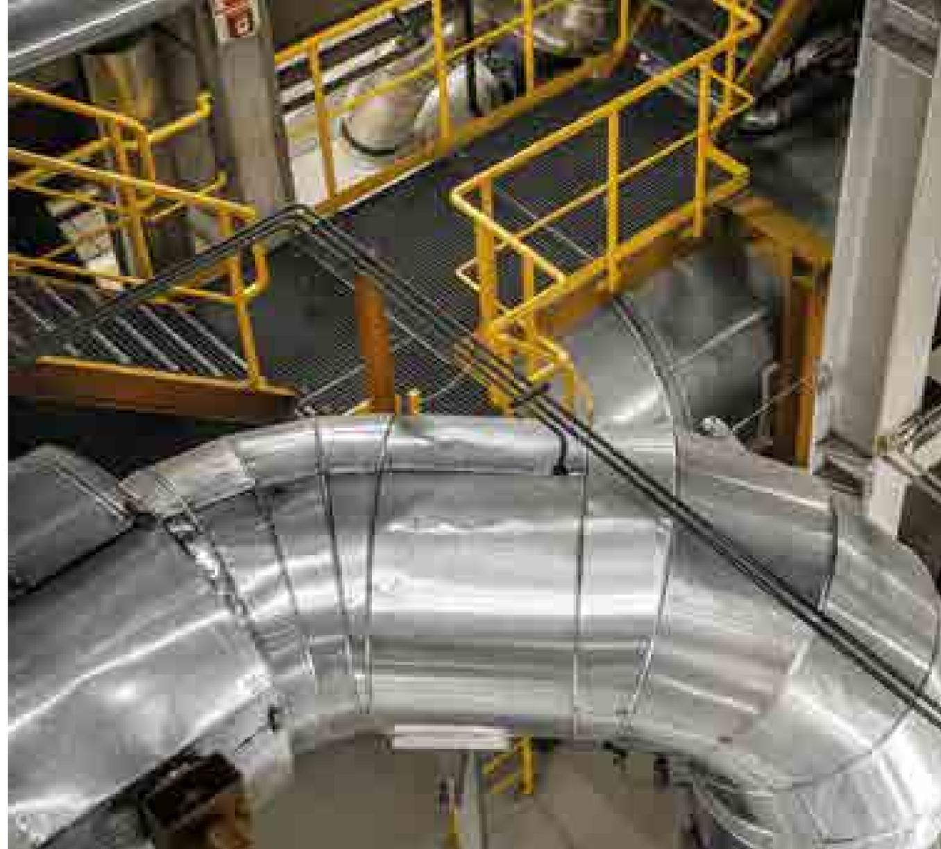
**Le caillebotis électroformé se compose de barres insérantes en carrés torsadés, électrosoudées dans les barreaux porteurs.**
