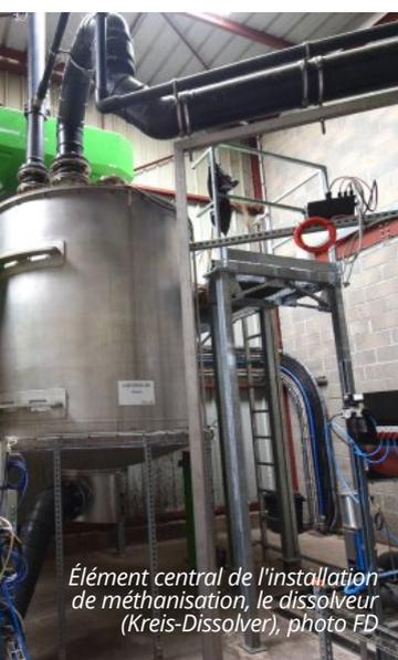
Élément central de l'installation de méthanisation, le dissolvant (Kreis-Dissolver), photo FD
