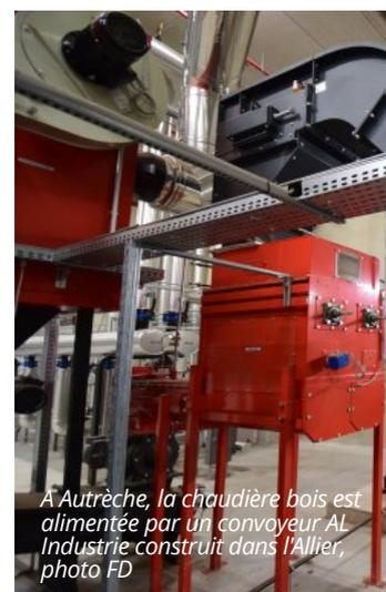
À Autrèche, la chaudière bois est alimentée par un convoyeur AL Industrie construit dans l'Allier, photo FD
