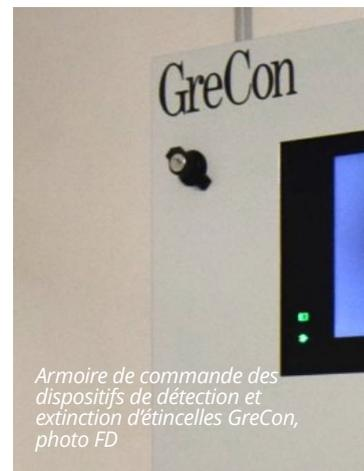
Armoire de commande des dispositifs de détection et extinction d'étincelles GreCon, photo FD
