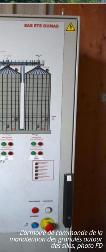
L'armoire de commande de la manutention des granulés autour des silos, photo FD
