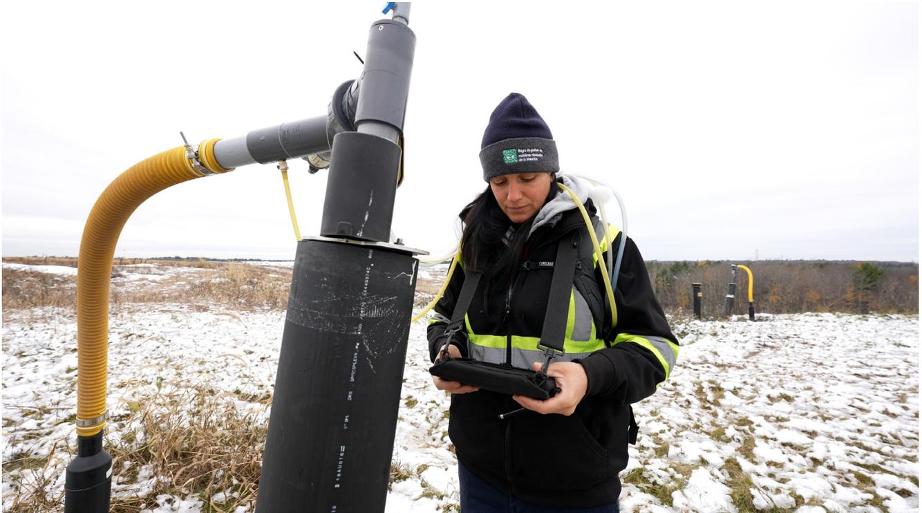
Mesure de la composition du gaz sur un puit de captage du site de Saint-Étienne-des-Grès (photo Enercycle)
