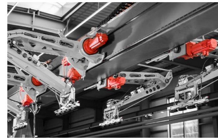
Abb. 1: Komplett automatisiert mit Antriebs- und Automatisierungstechnik von SEW-EURODRIVE – zentrales Element für die SCARA-Roboter ist die Softwarelösung MOVIKIT® Robotics.
