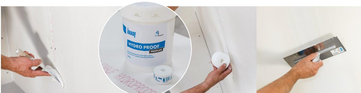
Enduisage et mise en place de la bande à joint **Knauf HydroProof®** avec l'enduit prêt à l'emploi **Knauf Proplak® HydroProof®** : facile à mettre en œuvre, pour un rendu très blanc et une finition parfaite.
