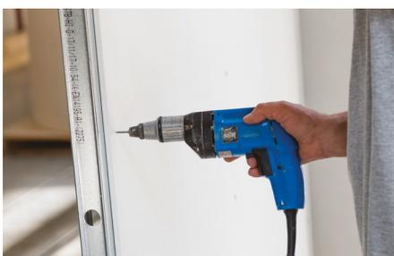
Vissage des plaques **Knauf HydroProof®**
