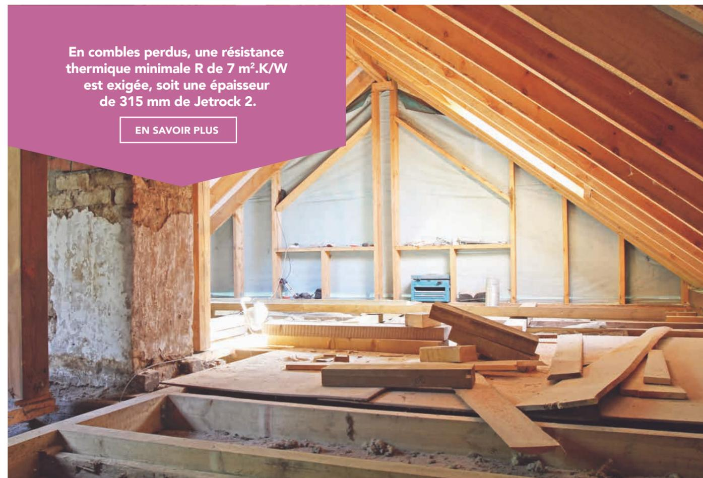
En combles perdus, une résistance thermique minimale R de 7 m<sup>2</sup>.K/W est exigée, soit une épaisseur de 315 mm de Jetrock 2.
