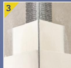
3. Après séchage, utiliser un enduit de finition tout usage pour une couche d'enduit minimale de 1mm.
