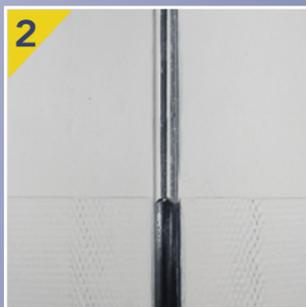
2 Enduire une première fois les deux ailes avec une couche primaire, puis une deuxième fois avec un enduit de finition tout usage pour une couche d'enduit minimale de 1mm.
