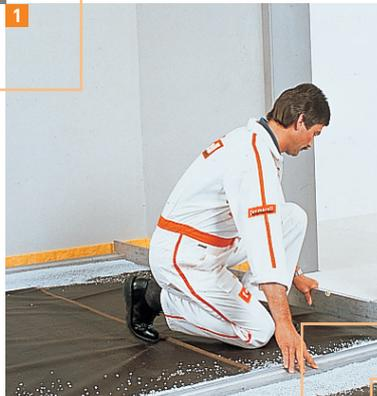
Verser les granules sur 20 cm de large sous forme de « digue » et niveler à hauteur désirée en tenant compte de l'épaisseur de la chape sèche. La digue se nivelle avec la règle FERMACELL pour ragréage avec niveaux intégrés. Parallèlement à cette digue, à une distance égale à la longueur d'une règle d'égalisation, réaliser la même opération.
