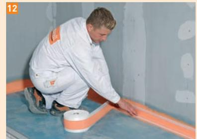
12 Presser la bande d'étanchéité FERMACELL dans la couche d'étanchéité encore liquide
