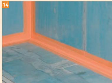
14 Lors d'une sollicitation faible à modérée à l'eau seul les angles sont traités avec le système d'étanchéité FERMACELL
