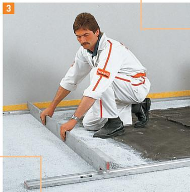
Ensuite les granules d'égalisation FERMACELL se tirent avec la règle. Comme il n'est pas possible de marcher directement dessus il faut commencer l'épandage au point le plus éloigné de la porte. Lors de la pose des plaques de sol, disposer des îlots sous forme de plaques de sol placées çà et là sur les granules.
