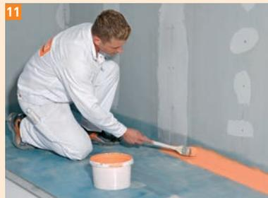
11 Appliquer avec un pinceau l'étanchéité liquide FERMACELL dans les angles
