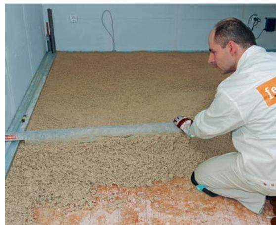
Réalisation de grande hauteur de remblayage de 40 à 2000 mm
