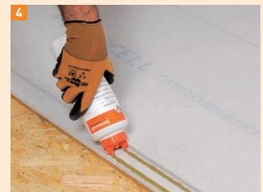
**4** Appliquer la colle en deux cordons sur la battue inférieure d'une plaque avant de la recouvrir par la battue supérieure de la plaque suivante.
