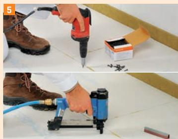
**5** Visser ou agraffer les battues l'une sur l'autre, de façon à assurer la compression nécessaire à la parfaite tenue du collage. 15 vis FERMACELL/m<sup>2</sup>
