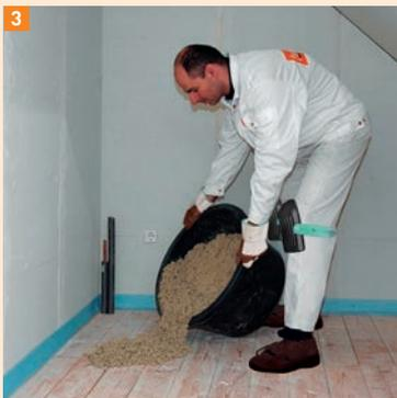
3 Après le mélange, le mortier peut être répandu sur le support
