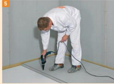
5 Assembler avec les vis Powerpanel ...
