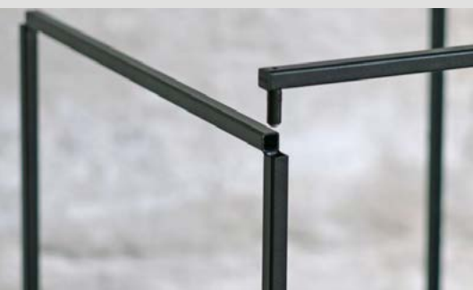
Mini profilé en acier, assemblage par emboîtement
