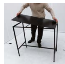
Installation du plancher
