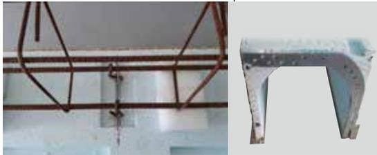
RENFORT DANS COFFRE PERMETTANT DE REPREDRE LE CHAÎNAGE DU LINTEAU ET ASSURER LA REPRISE « OBLIGATOIRE\* » DE LA TRAVERSE HAUTE DE LA MENUISERIE
