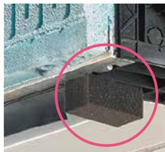
JOINTS DE PERMÉABILITÉ À L'AIR
