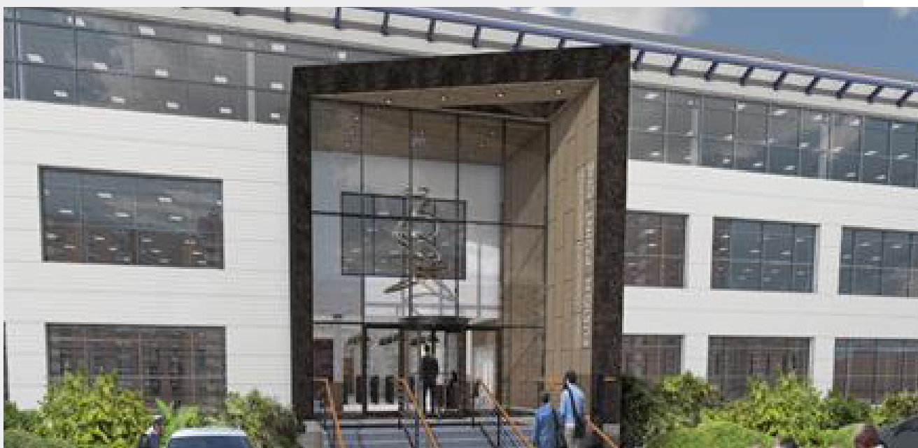
Rénovation d'un immeuble de bureaux à Cardiff afin de le rendre plus durable.
