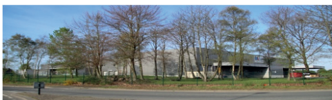
TALENDI - Rue du Boisillon à Tréguieux (22)
