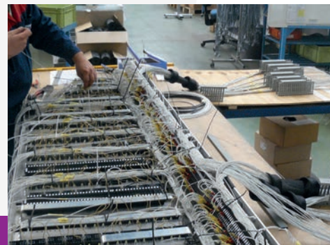
Reprise de câblage platines Électriques
