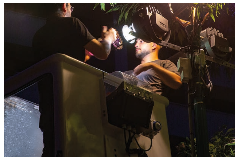
Le technico-commercial de WE-EF et l'installateur positionnent le GOBO dans le projecteur FLC.
