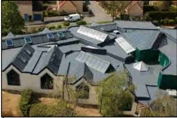
Ecole Les Renondaines - La Ville du Bois (91)
