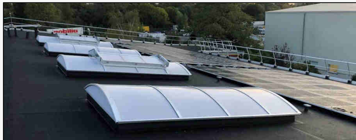
Av Marcelin Berthelot – Villeneuve-la-Garenne (92)
