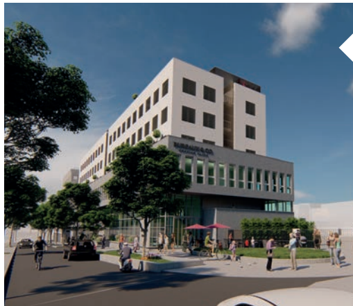
Construction par IDEC GRAND SUD d'un espace de co-working pour BUREAUX&Co à Montpellier (34), développé par GROUPE IDEC INVEST
