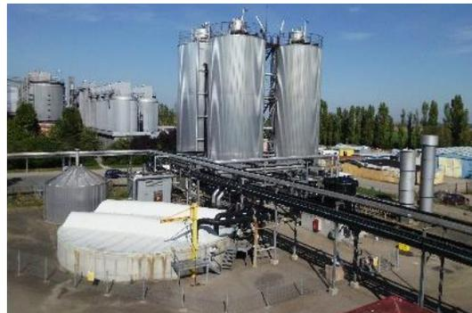
⇒ SUEZ exploite pour le compte d'une grande brasserie **à Obernai (67)**, une station d'épuration d'une capacité de 350 000 habitants. Les eaux usées chargées de levures y sont méthanisées avec 3 réacteurs et génèrent **19 000 MWh** thermique, de quoi fournir **18%** de l'énergie de la brasserie. Une fois traité, ce gaz est réintroduit dans le cycle de production et utilisé comme combustible dans les chaudières de la brasserie.
