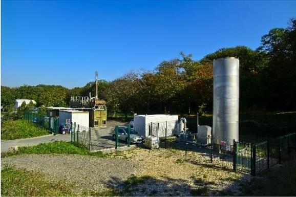
⇒ **À Pont à Mousson (54)**, 14 bâtiments publics et privés sont alimentés en eau chaude sanitaire et en chauffage grâce à la construction d'un réseau de chaleur de 6,7 km relié à une **chaufferie biogaz** située sur l'installation de stockage non dangereux de Lesménils (ISND).
