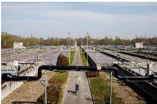
⇒ **La station d'épuration de Strasbourg (67)** a été la première en France à transformer le biogaz produit par la digestion des boues, issues des eaux usées, en biométhane : c'est Biovalsan ! Ce gaz vert est réinjecté dans le réseau de distribution et représente la production de plus **d'1,6 million de m3** de biométhane par an, soit **l'équivalent de ce que consomment 5000 logements BBC.**
