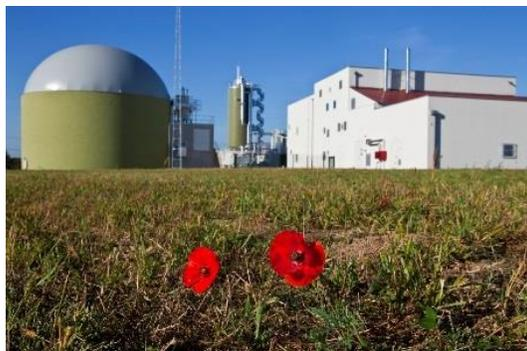
⇒ **À Meistratzheim (67), la station de traitement des eaux usées** produit **5464 MWh** par an, soit **l'équivalent de la consommation énergétique annuelle** de 2200 habitants. Le biogaz produit à partir du jus de choucroute est mélangé à celui issu de la digestion des boues d'épuration et permet de chauffer l'ensemble des installations. L'excédent énergétique est réinjecté dans le réseau électrique grâce à une cogénération.
