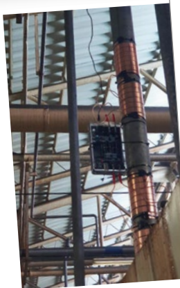
Vulcan S25 a été installé à quelque 50 mètres en amont de la machine de trempe par induction.
