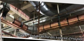
Étape 1 : Installer les bandes à courant d'impulsion
