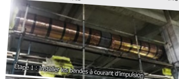
Étape 1 : Installer les bandes à courant d'impulsion
