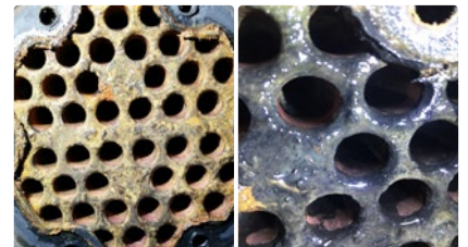
Faisceau tubulaire d'un échangeur de chaleur
