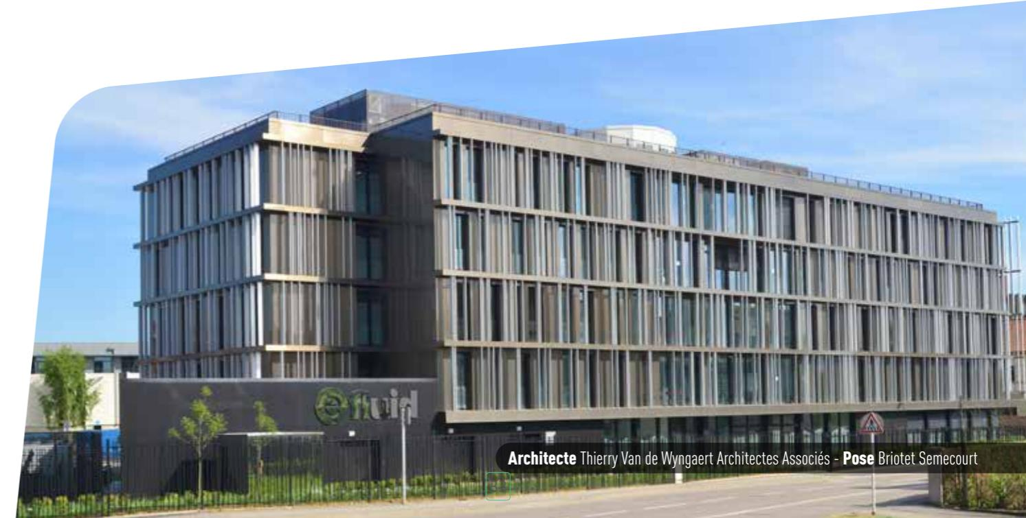
Le **pilotage** des brise-soleil orientables garantit l'angle d'inclinaison **idéal** des lames pour **contrer** les rayons directs du soleil et **conserver** un maximum de luminosité.
