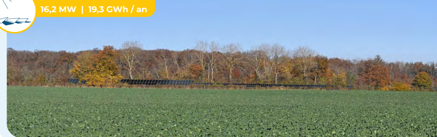
Centrale photovoltaïque de la Chalotterie Commune de Herry, Cher (18)
