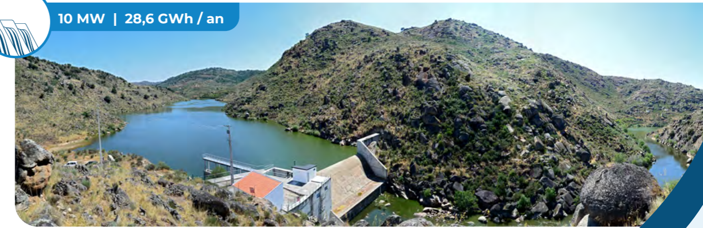
Centrale hydroélectrique Senhora de Monforte District de Guarda - Portugal
