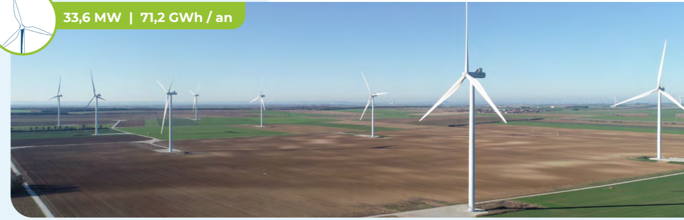
Parc éolien des Puyats Communes de Champfleury & Plancy l'Abbaye, Aube (10)
