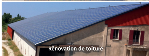
Construction de bâtiment agricole
