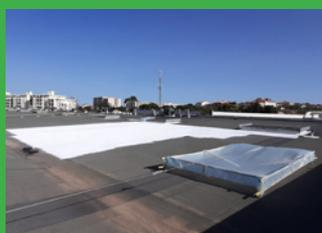
Application du revêtement sur supports bitumineux, fibrociment non amianté, bac acier, selon les recommandations de la fiche technique.
