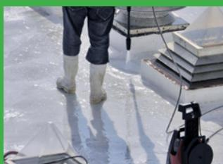
Les supports seront conformes à leur DTU respectif. Nettoyage du support par tout moyen approprié (brossage, rinçage ou lavage HP). Traitement des moisissures et mousses suivant la fiche technique du produit.
