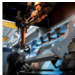
12 îlots de soudage robotisés.
