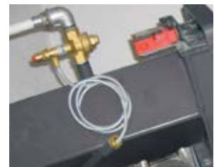
Sécurité thermique supplémentaire par vannes d'aspersion
