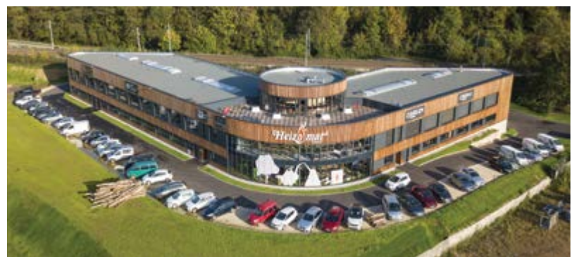
Nouveau siège et base technique et commerciale en Savoie (73) en bordure de l'A43
