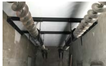
HSK-RA 200 X2 Commune de Queige (73) Réseau de chaleur communal Chaufferie avec 2 chaudières, trémie double de remplissage et 2 vis de répartition.
