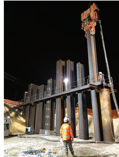
BATTAGE DE PALPANCHES BONNEUIL SUR MARNE 94
