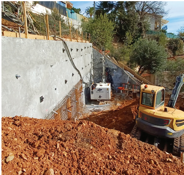
PAROI COULÉE DÉFINITIVE - ROQUEBRUNE-CAP-MARTIN 06
