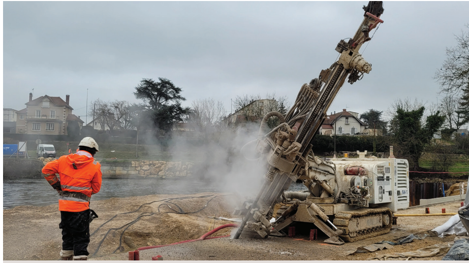
FORAGES ET INJECTION SEUIL DU BARRAGE - AUXERRE 89
