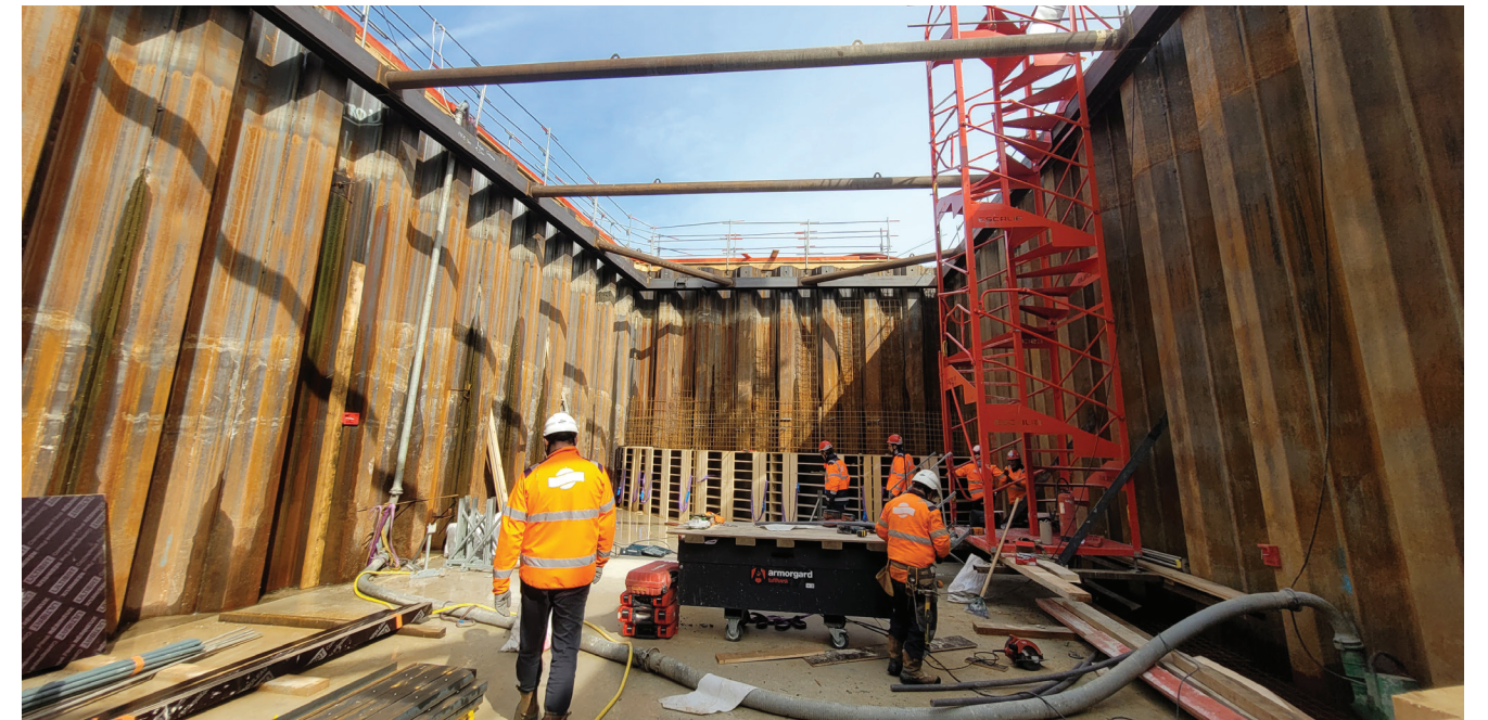
BATARDEAU EN PALPLANCHES - RHINAU 67
