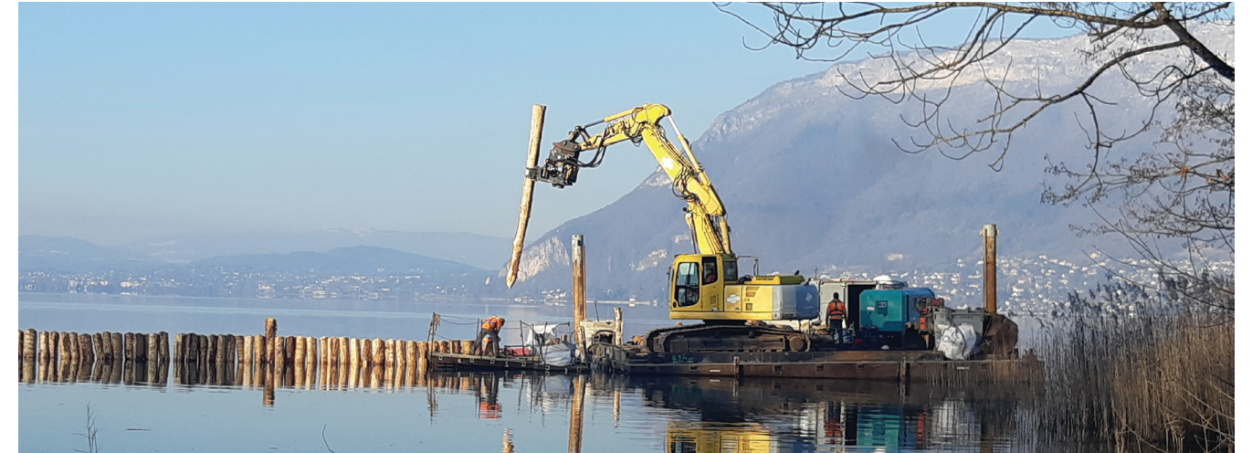
BATTAGE PIEUX BOIS - SÉVRIER 74
