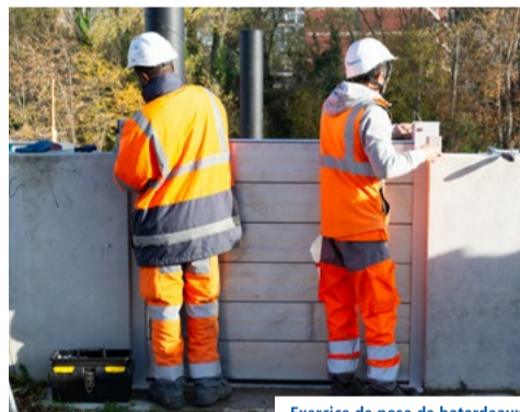
Exercice de pose de batardeaux
