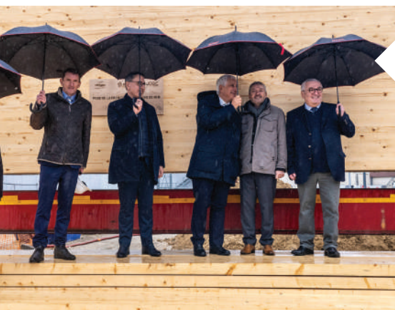
Levée de poutres d'une plateforme logistique pour la SEMMARIS à Rungis (94) par IDEC.
