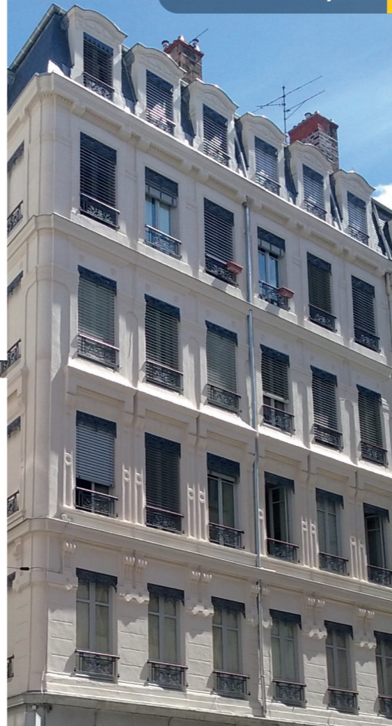
TRAVAUX SUR FAÇADE
