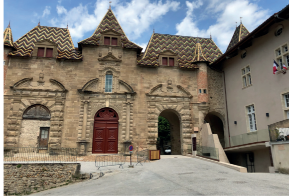
RESTAURATION BÂTI CLASSÉ
