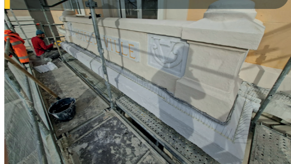
CONSOLIDATION STRUCTURE EN PIERRE
