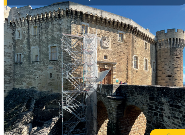
RÉHABILITATION MAÇONNERIE PATRIMONIALE
