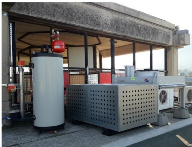
Groupe frigo alimenté par un champ de capteurs photovoltaïques avec possibilité d'ajustement en temps-réel de la puissance du groupe à la ressource solaire.
