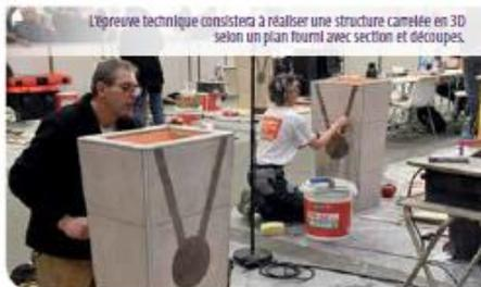
L'épreuve technique consistera à réaliser une structure carrelée en 3D selon un plan fourni avec section et découpes.
